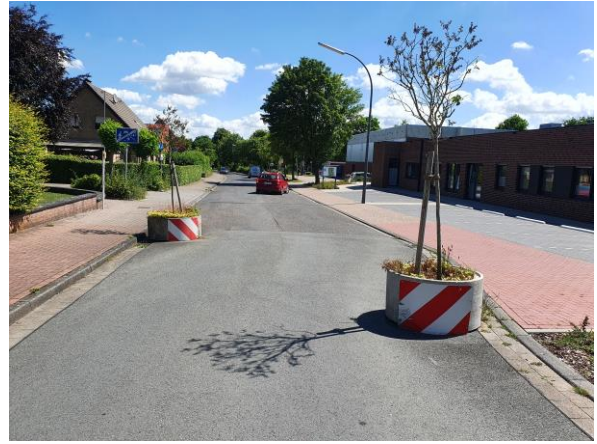
Abbildung 55 - versetzte Baumkübel als geschwindigkeitsdämpfende Elemente im Bereich St.-Josef-Kinderergarten / Gym. Arnoldinum Horstmar
